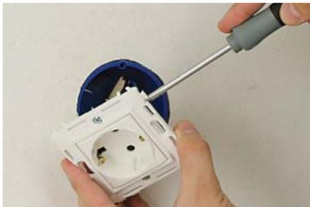
Подсоедините провода к розетке. Установите собранное изделие в коробку (диаметр коробки 65-68 мм, глубина более 40 мм)
