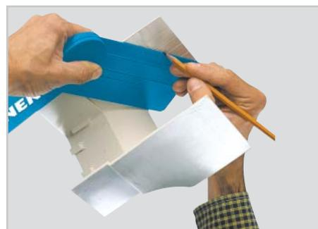
При углах больших или меньших чем 90° необходимо обрезать часть элемента угла
