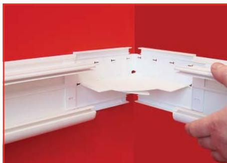
Вставьте в базу угла вторую часть кабель-канала и закрепите его на стене
