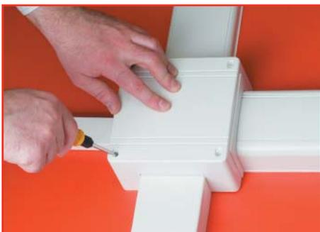
Установите крышку коробки и прикрутите ее к базе винтами
