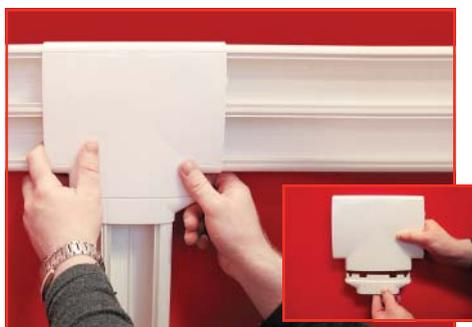
При отводе кабель-канала 90x50 мм от 140x50 мм используется переходник 140-90x50 совместно с тройником
