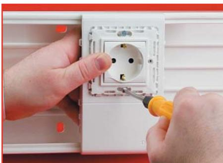
Электроустановочное изделие в каркасе с посадочным размером 60 мм фиксируется в рамке при помощи 2-х винтов-саморезов, поставляемых в комплекте с рамкой PDA-N
