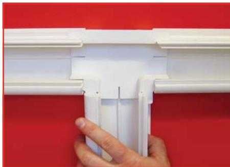
Вставьте в базу тройника отводимый кабель-канал и закрепите его на стене
