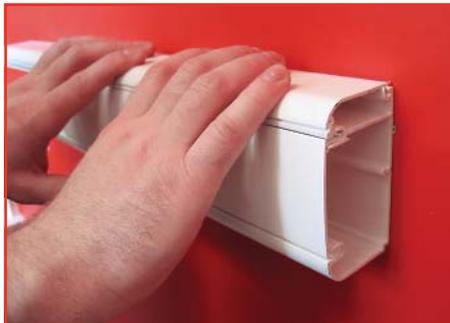
Опустите крышку и вставьте ее в ближний паз кабель-канала
