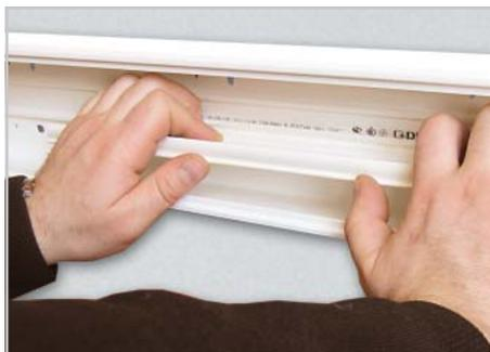
Разделитель устанавливается защелкиванием на направляющие дна короба
