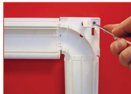
Вставьте в базу угла вторую часть кабель-канала и закрепите на стене
