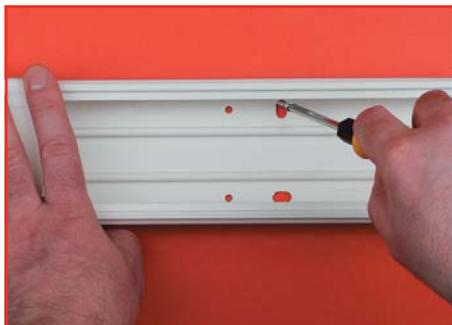
Короб крепится к стене на винтах-саморезах (крепеж см. в разделе "М5 Combitech") через перфорацию на основании
