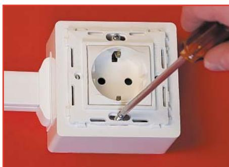
5. Прикрутите каркас с розеткой / выключателем к коробке при помощи саморезов, поставляющихся в комплекте
