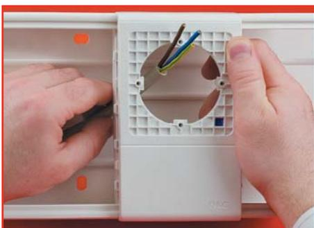
Рамка PDA-N с фиксатором монтируется в короб защелкиванием аналогично рамке PDA, монтаж которой описан ранее
