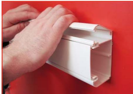
Кабель-канал 90x50 мм устанавливается боковой крышкой вверх. Установите крышку в дальний паз кабель-канала
