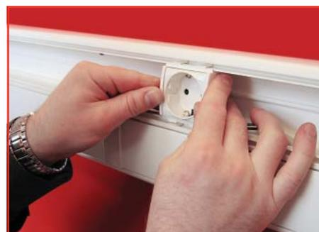
Установите каркас с электроустановочным изделием защелкиванием
