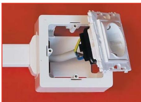
4. Подсоедините провод к изделию, предварительно установленному в каркас
