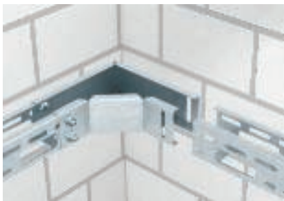
Установка фасонной детали кабельного лотка для монтажа светильников
