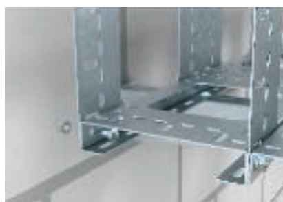
Монтаж донного профиля
