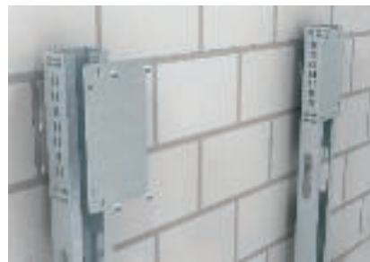
Установка монтажной пластины
