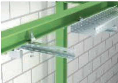
Консоль на стальной балке
