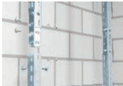
Соединение U-стоек
