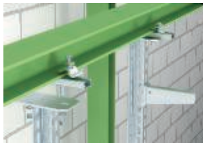
Фиксация C-образного профиля при продольном направлении прокладки трассы
