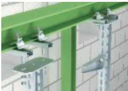
Фиксация C-образного профиля при поперечном направлении прокладки трассы
