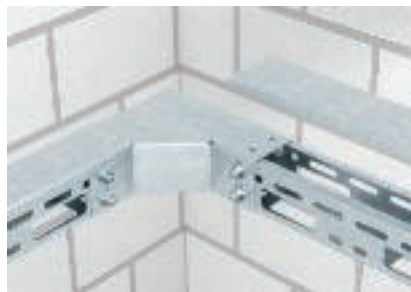
Установка крышек фасонных деталей для кабельных лотков для монтажа светильников
